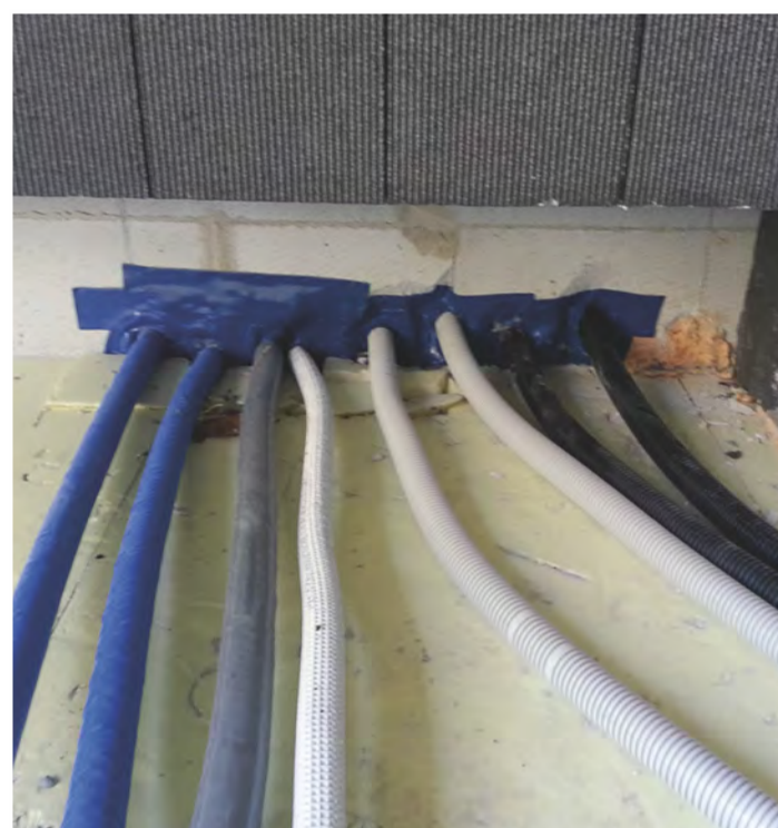
LA SIGILLATURA di tutte le tracce degli impianti è uno degli aspetti rilevanti per garantire la migliore tenuta all'aria dell'involucro edilizio, fattore determinante per garantire minime dispersioni termiche.
