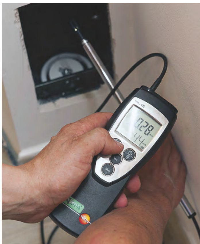
IL BILANCIAMENTO dell'impianto VMC è stato effettuato verificando le portate con un anemometro: in secondo piano la strozzatura della bocchetta impiegata per parzializzare il flusso dell'aria.
